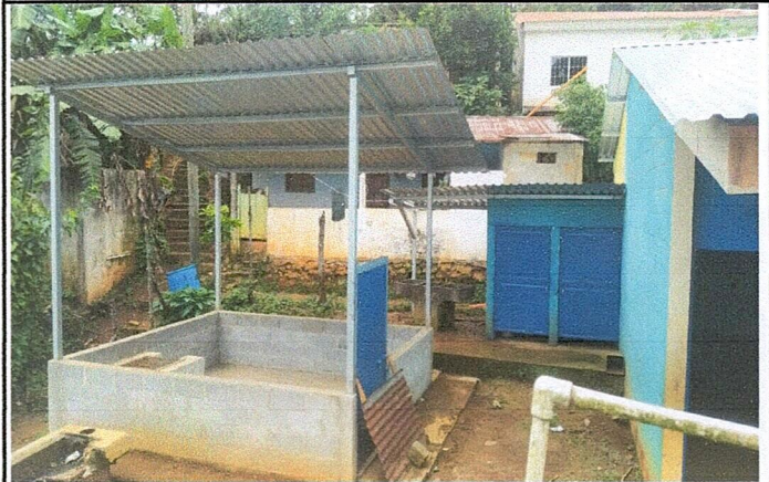
Foto 4: Vista general de avance de cocina.
